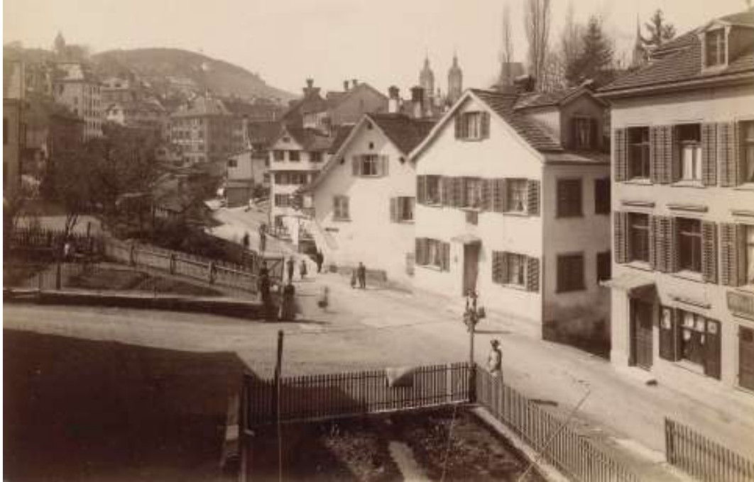
Mittlere Lämmli-brunnenstrasse, 9000 St. Gallen (nach 1893/94, nach Überdeckung der Steinach mit umgebungsheterogen-adessiven Gartenanlagen).
