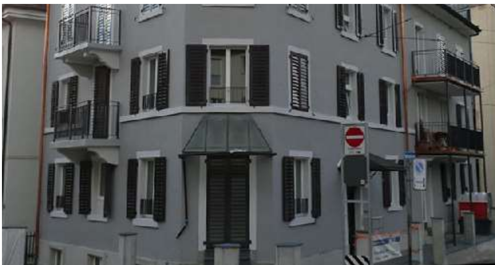
Vogelsangstr. 33, 8006 Zürich (nach Renovation 2014)
