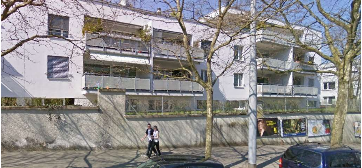
Ungefähre Lage des ehem. Rest. Morgensonne (2009)
