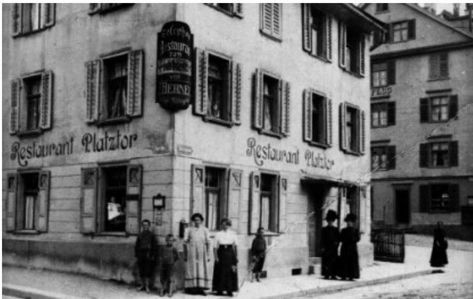
Ehem. Rest. Platztor, Goliathgasse 40, 9000 St. Gallen (um 1897)
